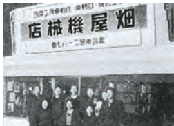
●東区宮町 煙屋機械店
